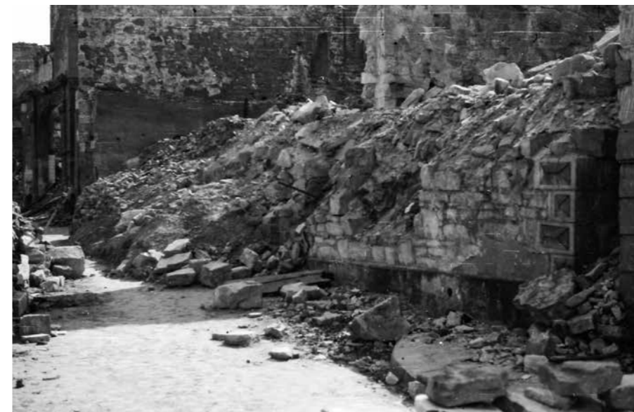
Die „Pinne“ ist bis auf die Grundmauern eingestürzt.
