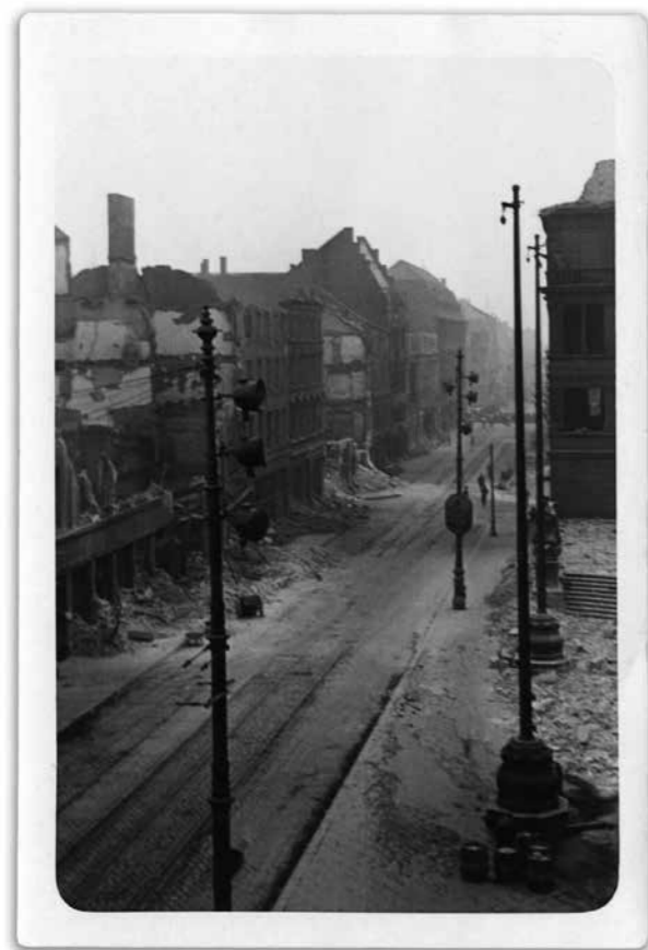
Kurz nach dem verheerenden Großangriff ist dieses traurige Motiv der Oberen Königsstraße entstanden. Noch ist der Schutt nicht geräumt. Zahlreiche Ruinen wurden in der Zeit danach gesprengt.
